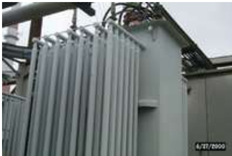
ნახ.4.47. ცივი გამაგრებული წიბოები, რაც გამოიწვია ზეთის დაბალი დონე
