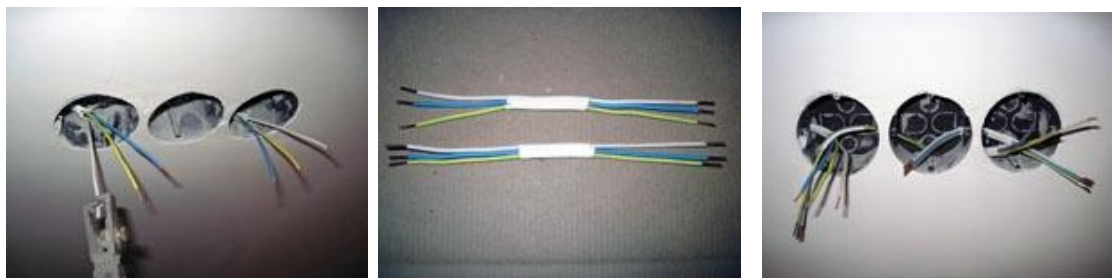
ა) ბ) გ) ნახ.8.41. გამტარის ბოლოების გასუფთავება (ა), შემაერთებელი გამტარების მომზადება (ბ) და ხვრელებში გატარებული გამტარები (გ)
