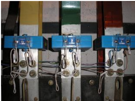
ნახ. 11.14. დენის ტრანსფორმატორების მონტაჟი სალტებზე
