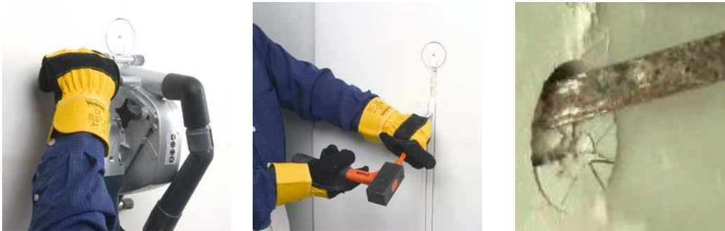
ნახ.8.25.სპეციალური მტკვრსასრუტით აღჭურვილი ღარსაჭრელი (ა)
