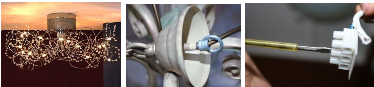
ნახ.8.60. დამონტაჟებული ჭადი (ა), ჩამოსაკიდი კაკვი (ბ) და კლემის კალაპოტი (გ)
